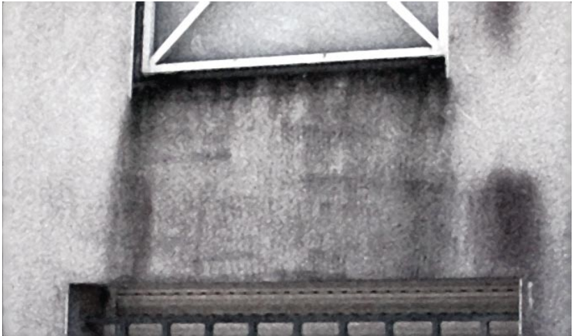
Apparition de micro-organismes sur une finition grattée.
